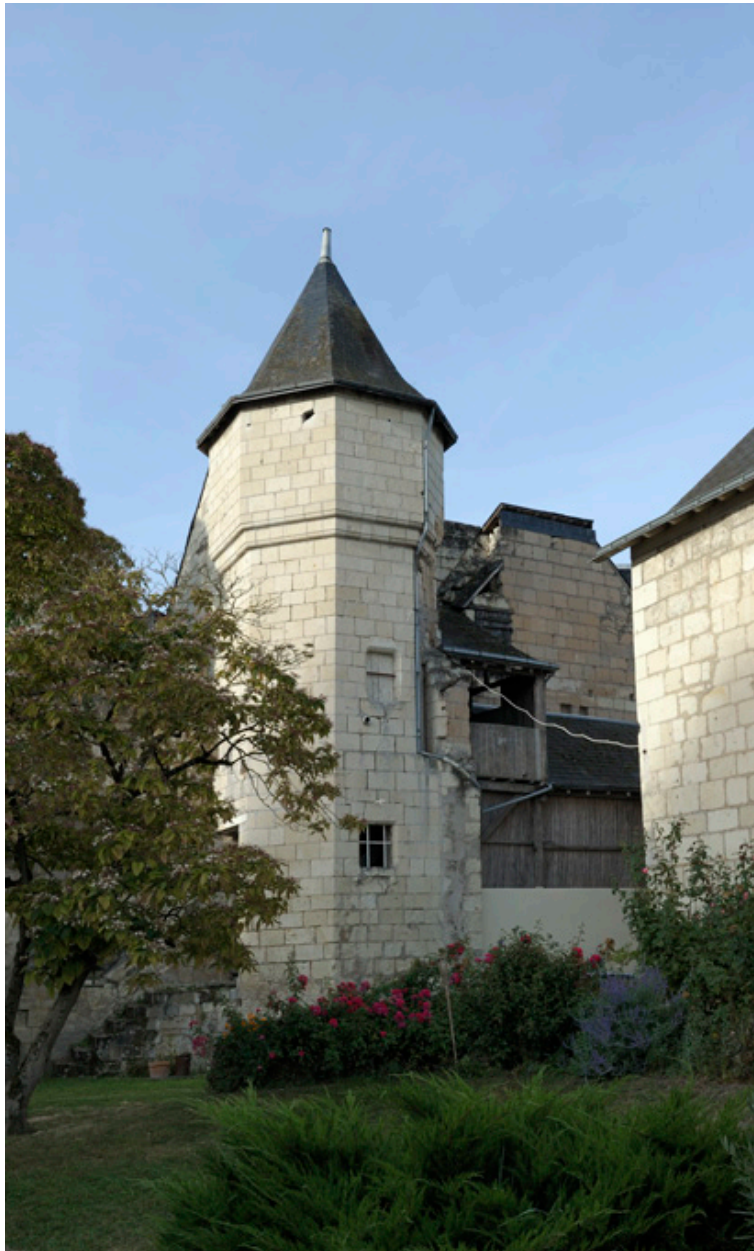
Tourelle d'escalier et mur intérieur de l'ancien pignon sud.
