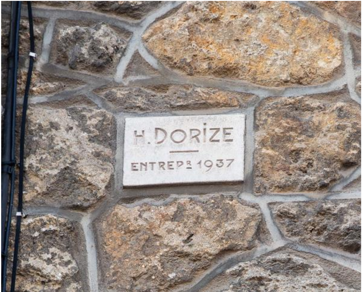
Vue de la plaque d'entrepreneur (Dorize) sur la maison boulevard Curie.
