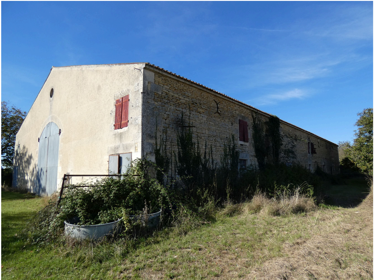
La grange-étable vue depuis le nord-est.
