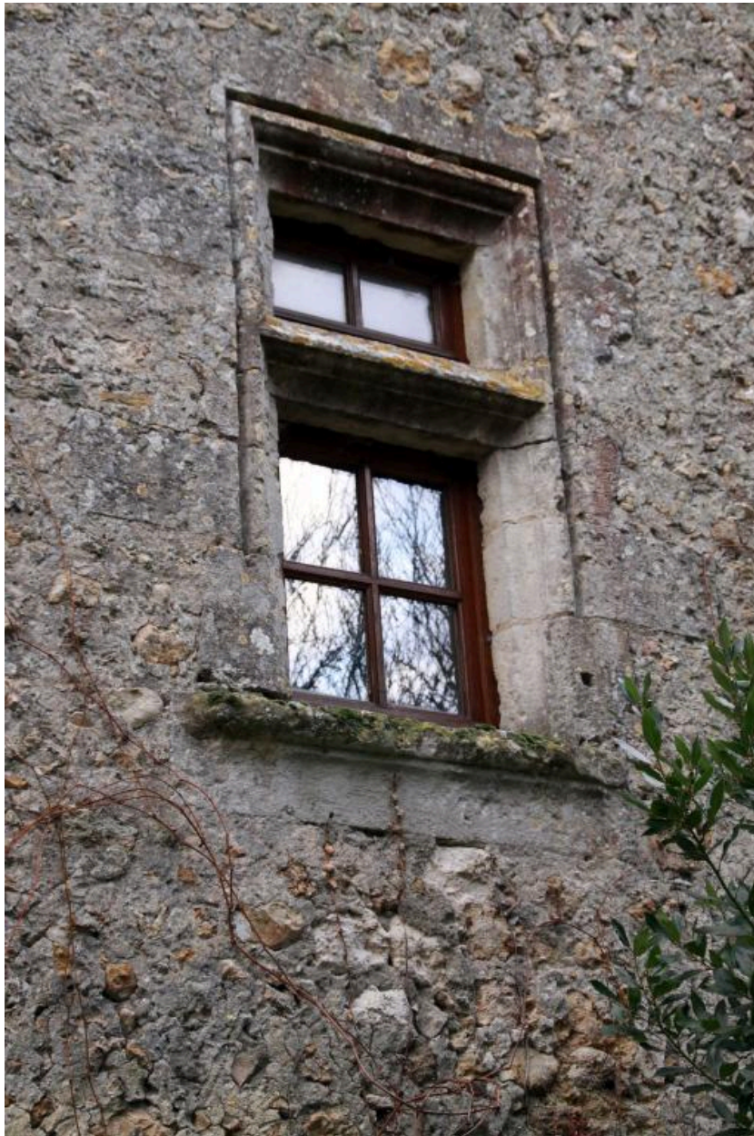
Logis, pignon nord-ouest : baie.
