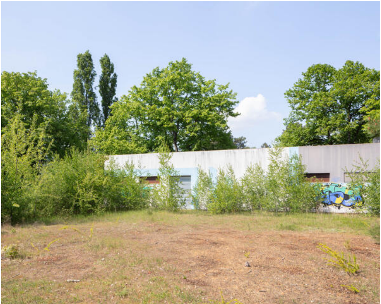
Vue de l'ancienne structure en dur de la piscine.
