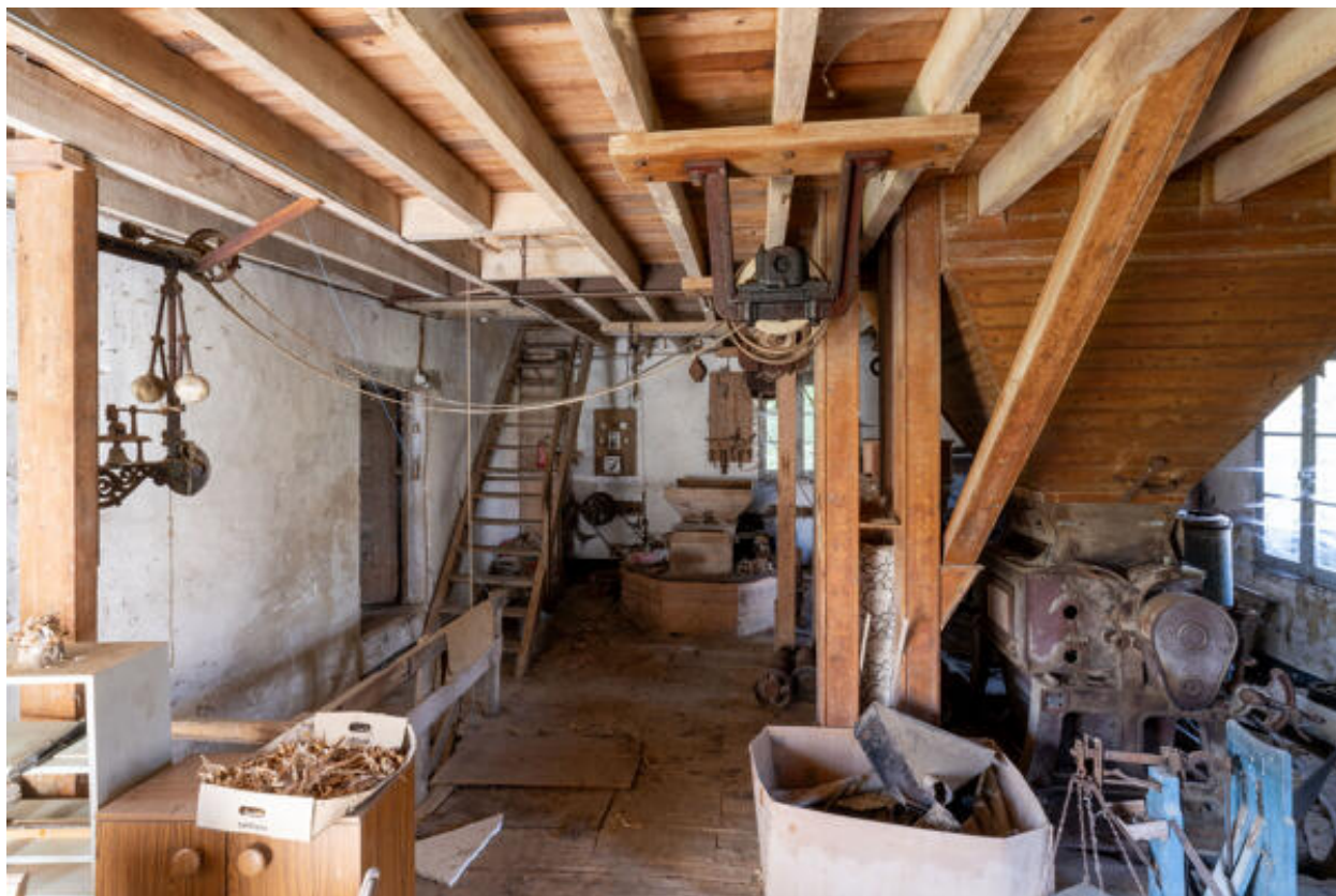
Machines du moulin : premier étage.
