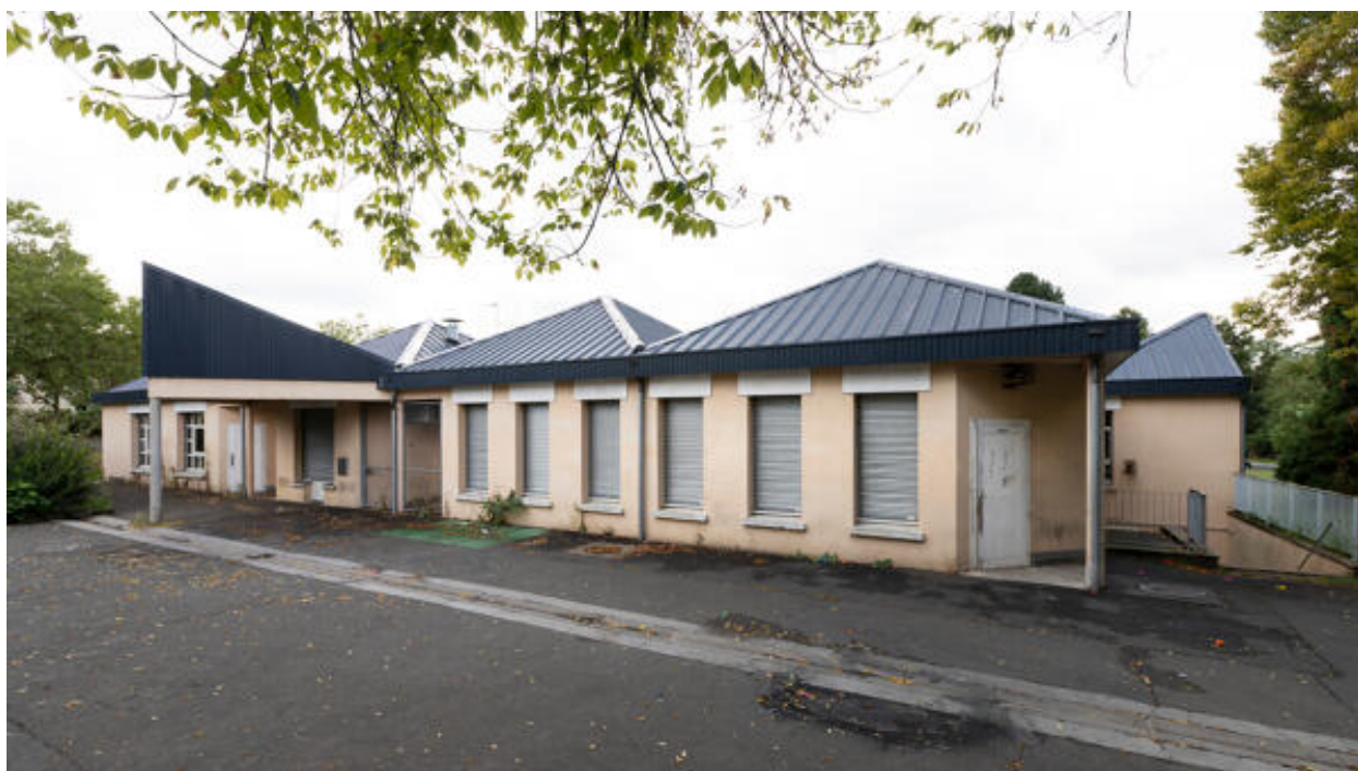
Vue du bâtiment depuis le nord.
