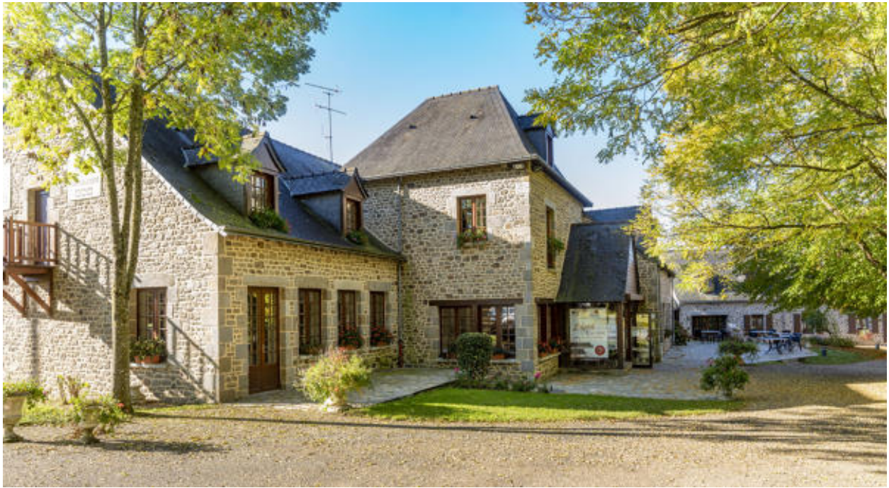
Les bâtiments de l'hôtel-restaurant.
