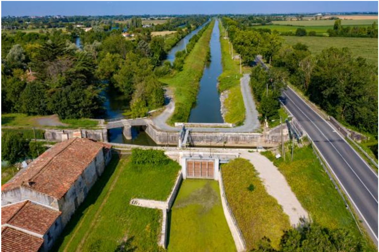
Vue aérienne depuis l'ouest.
