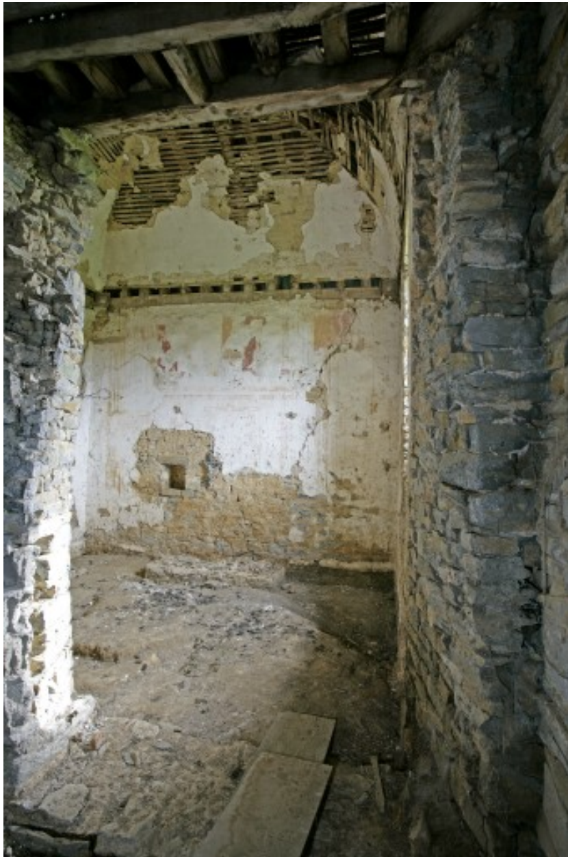
La chapelle : vue intérieure depuis le sud-ouest.
