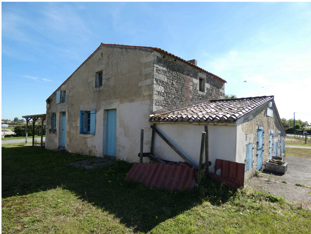
Le fournil et le toit à porcs vus depuis le nord-ouest.
