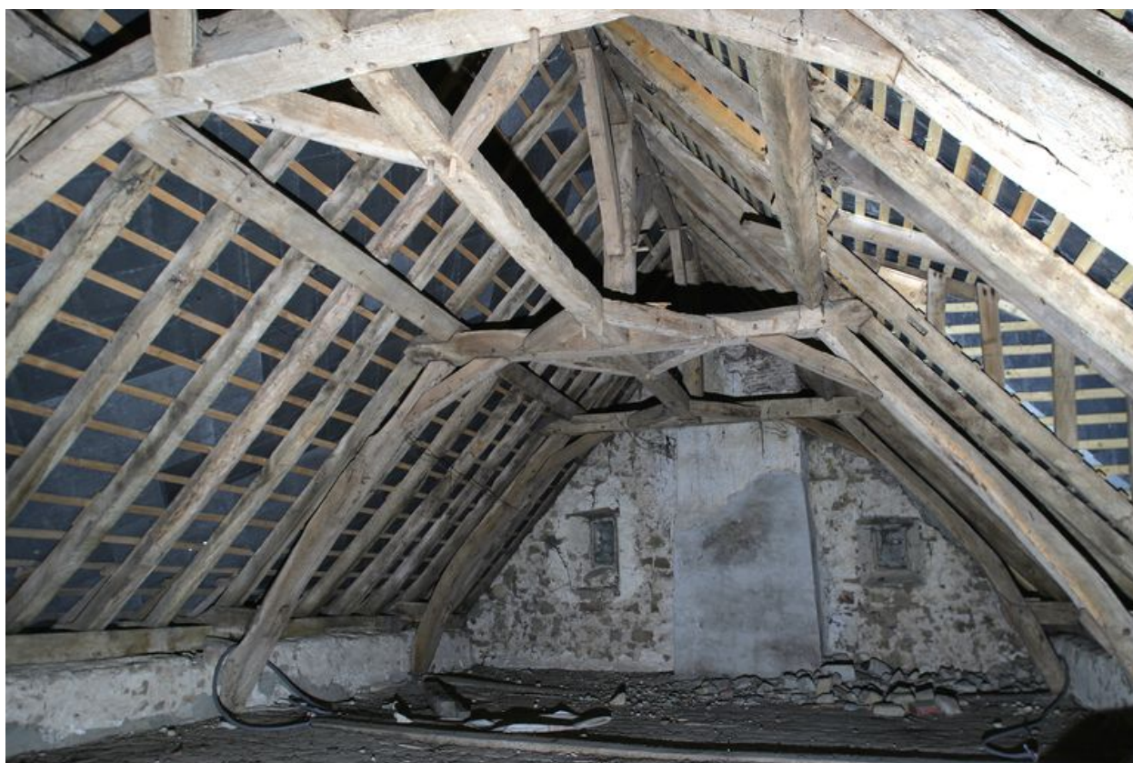
La charpente du logement.
