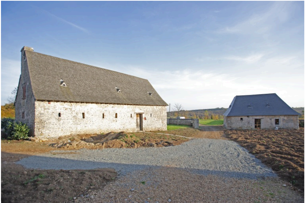
L'étable et la dépendance sud vues depuis l'ouest.
