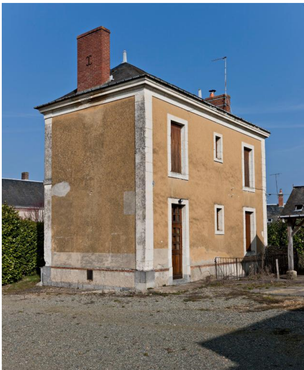
Ancien logement de l'instituteur : façade sur cour.
