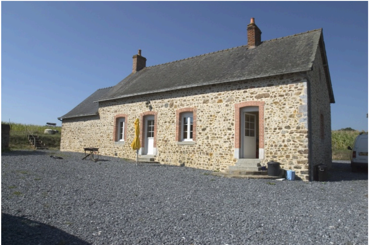
Ancienne ferme ouest : le logis.
