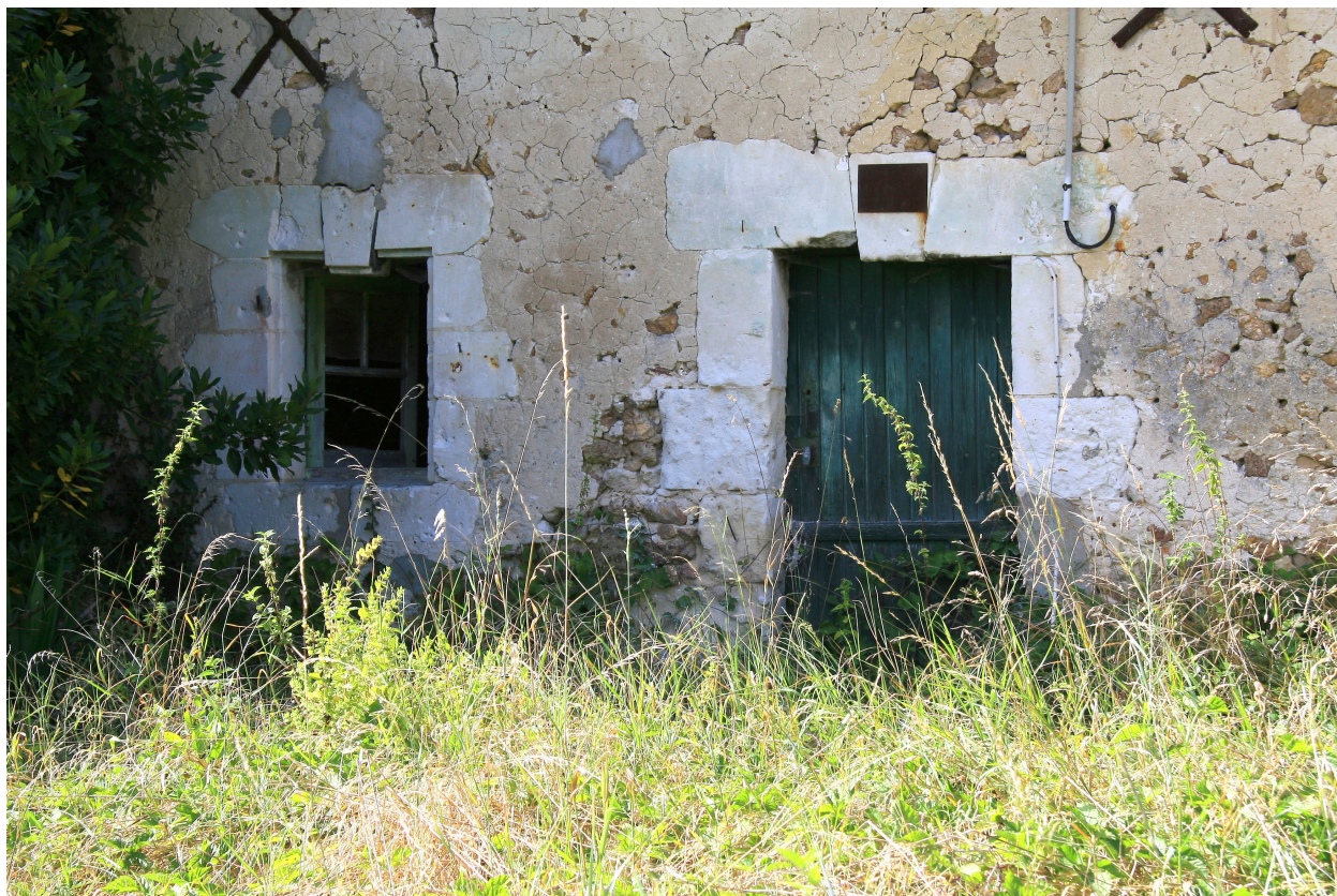
La maison du XVII e siècle : porte et fenêtre.
