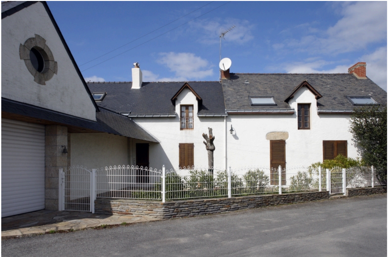
Vue du n° 26 rue du Château (façade sud).
