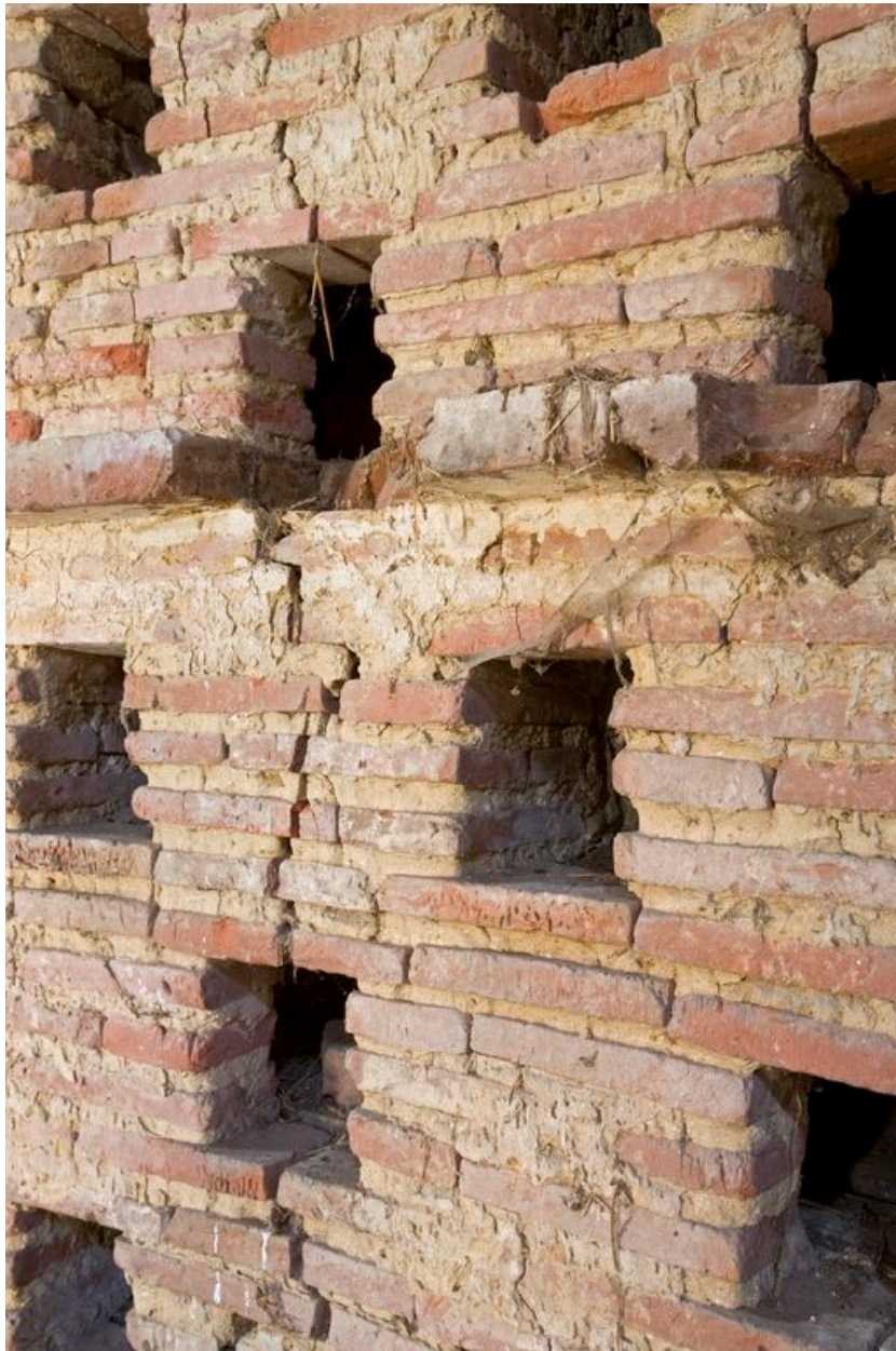
Détail de l'intérieur du colombier : boulins appareillés en briques
