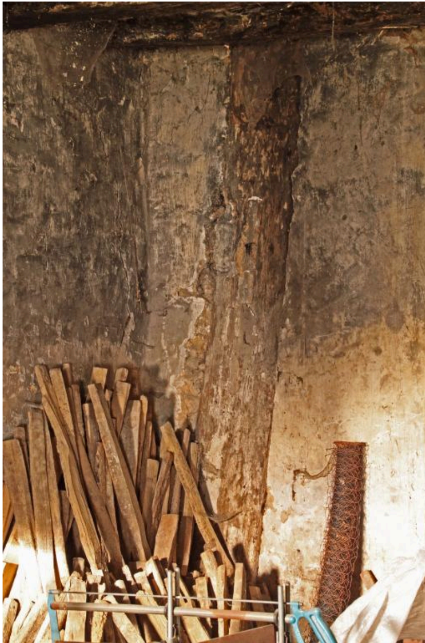
Maison : structure à pan de bois maçonnée.
