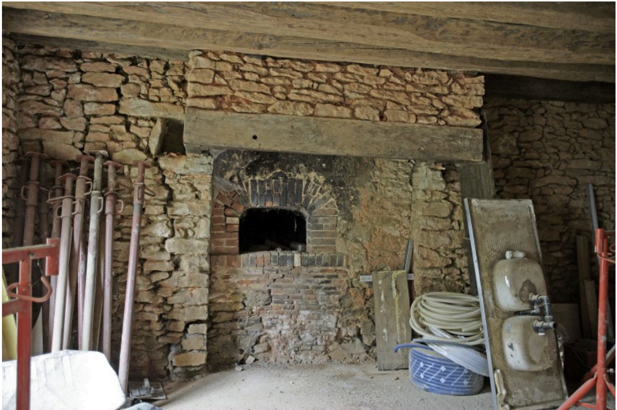
Logis : cheminée du fournil.
