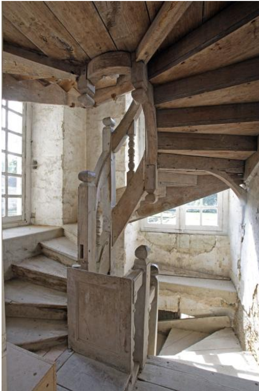
L'escalier secondaire du pavillon nord.
