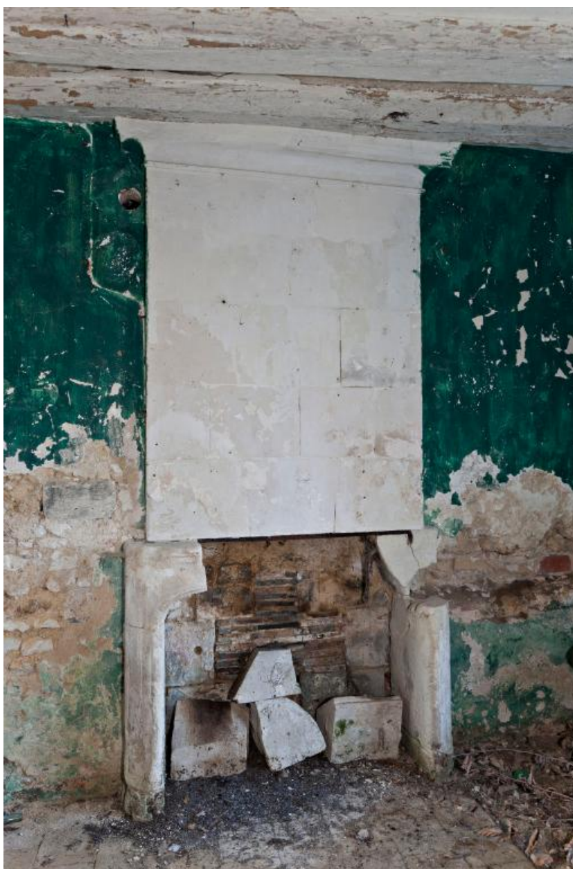
Dépendance 1, RdCh, autre pièce à feu : cheminée.
