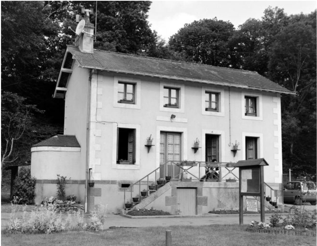
La maison éclusière.
