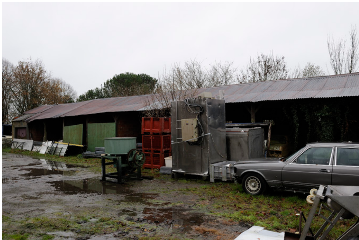
Hangar élevé dans la cour.
