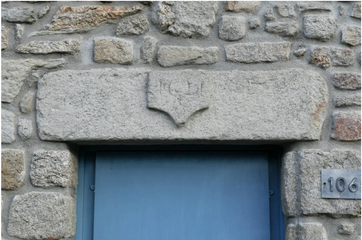
Façade sur rue, détail d'encadrement de porte.
