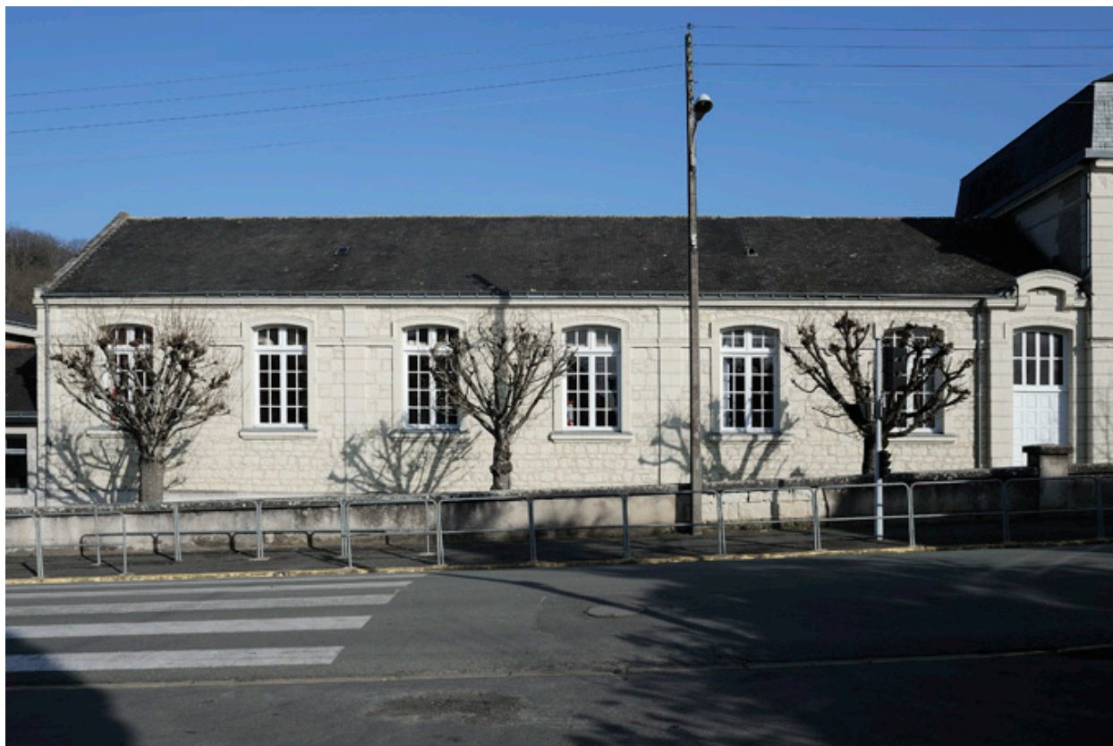
Ecole, façade ouest
