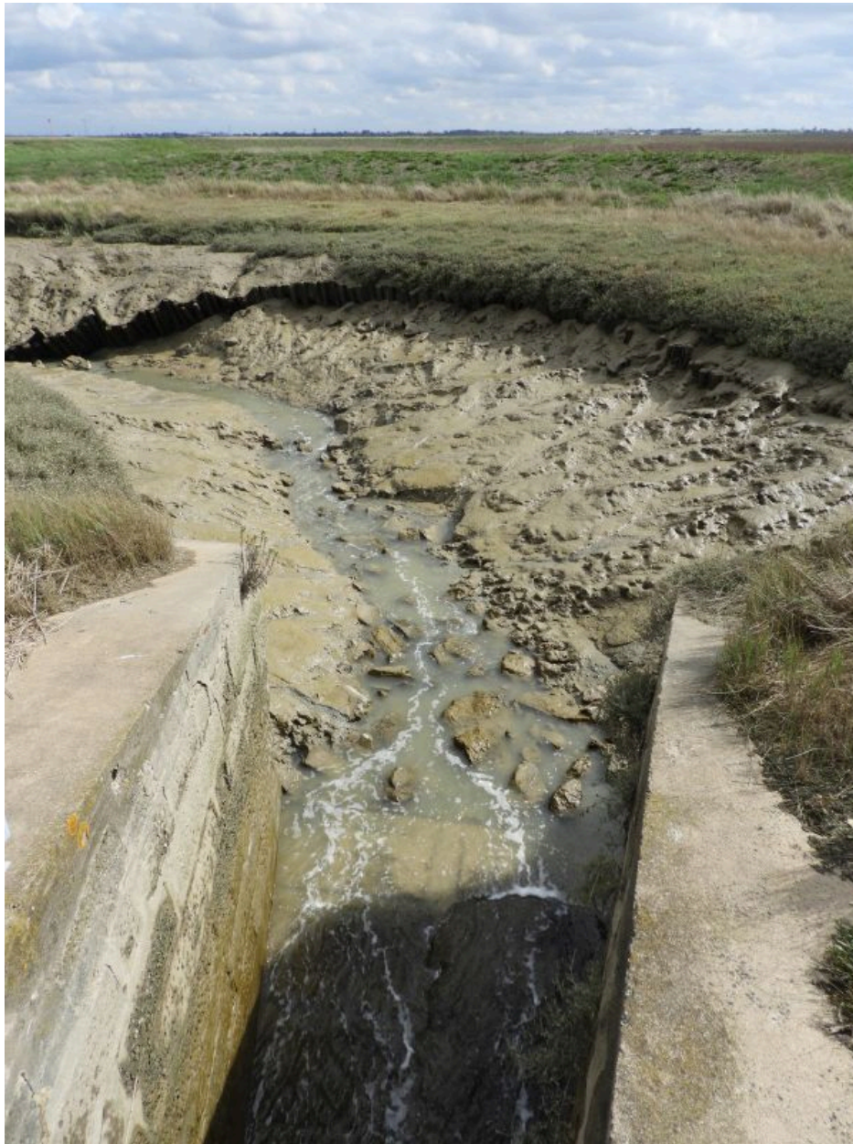
Le chenal juste en aval de la porte.
