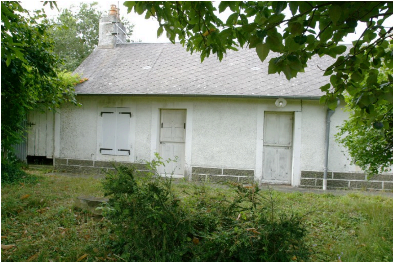
Vue depuis le sud.
