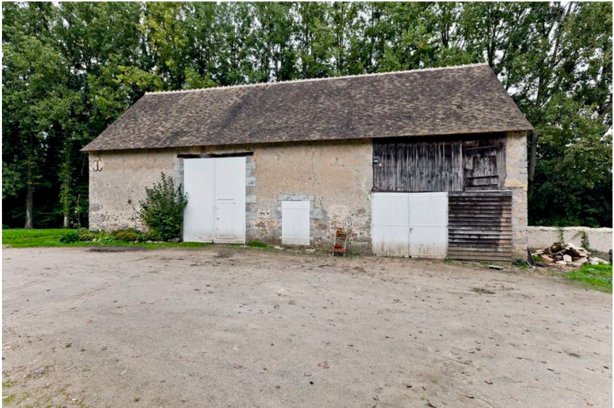
Élévation sur cour de la grange-étable-remise-fenil.
