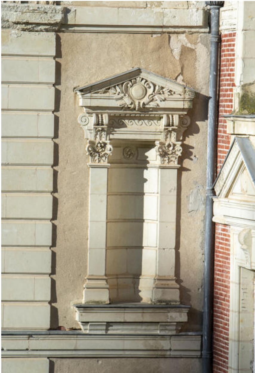
Une niche de l'élévation postérieure.
