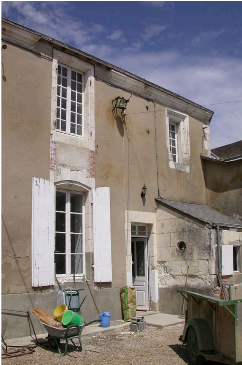
Façade antérieure sur la cour du vieux bâtiment.
