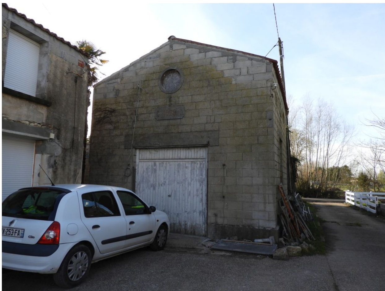
L'ancien abattoir vu depuis l'est.
