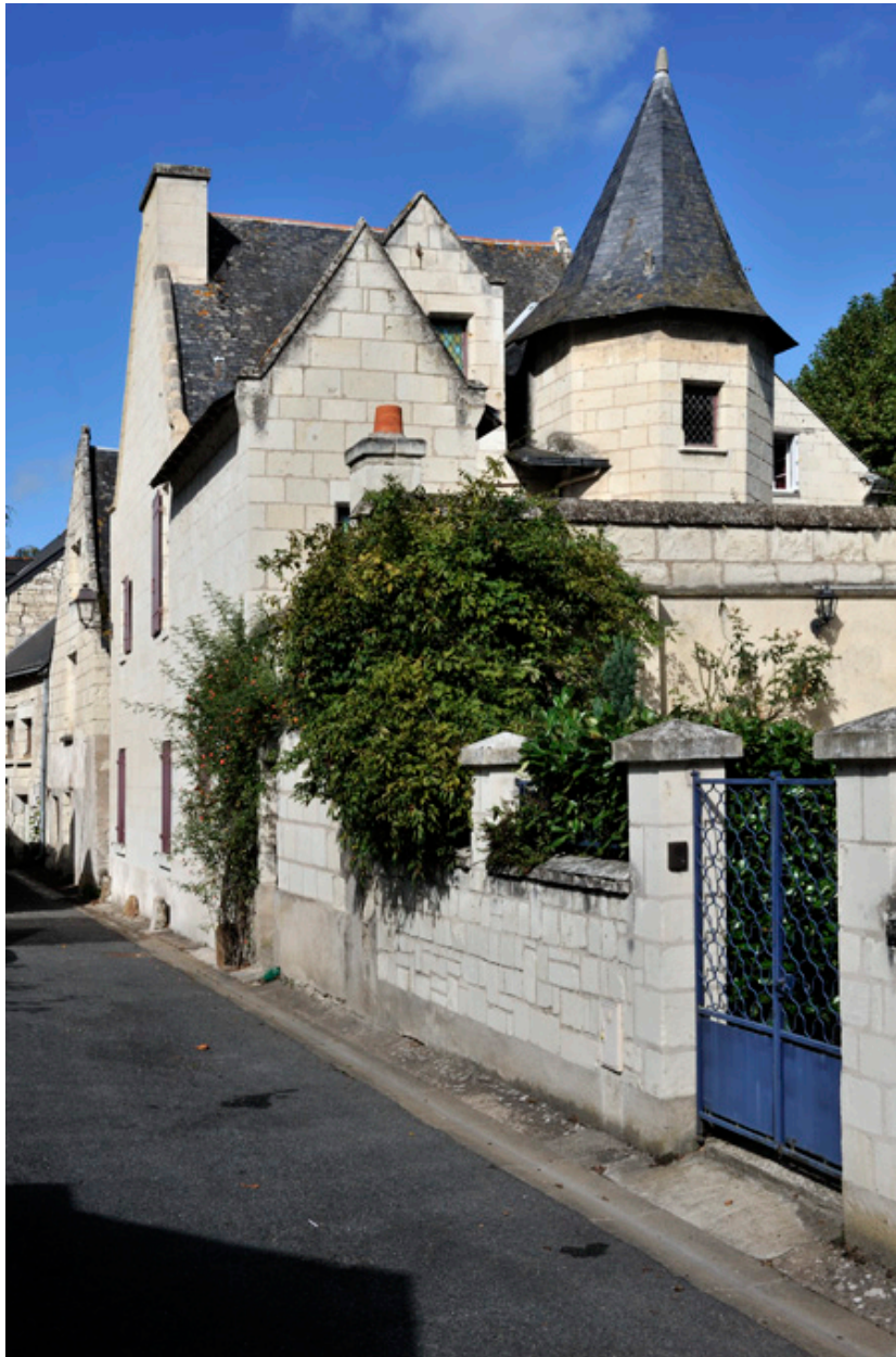
Vue d'ensemble depuis la Basse rue.
