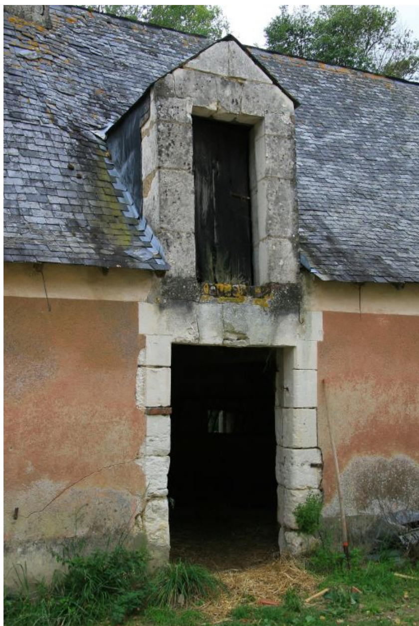
Parcelle 466 : la maison d'habitation, façade antérieure, détail.
