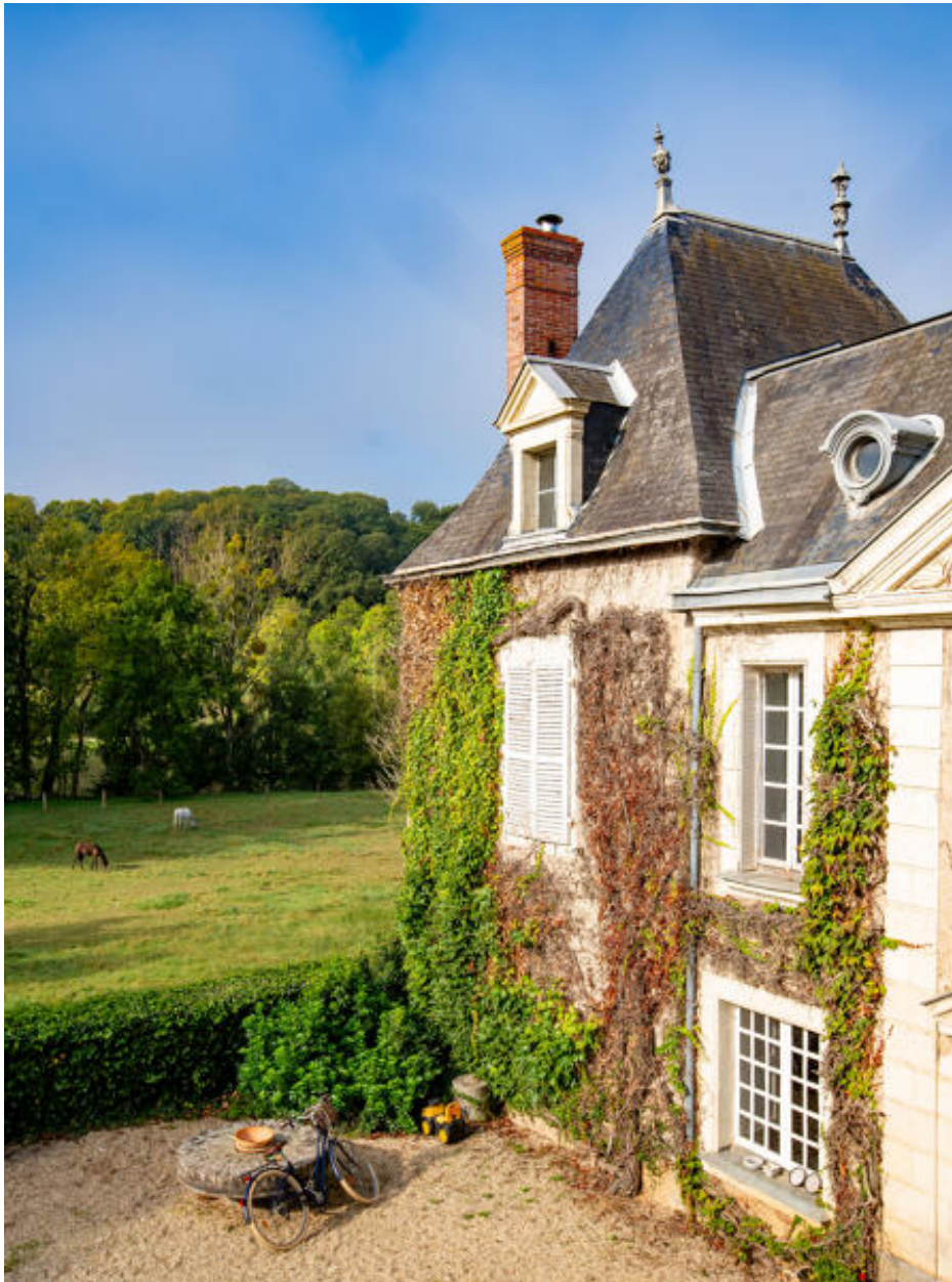
L'un des pavillons enserrant le corps de logis principal.
