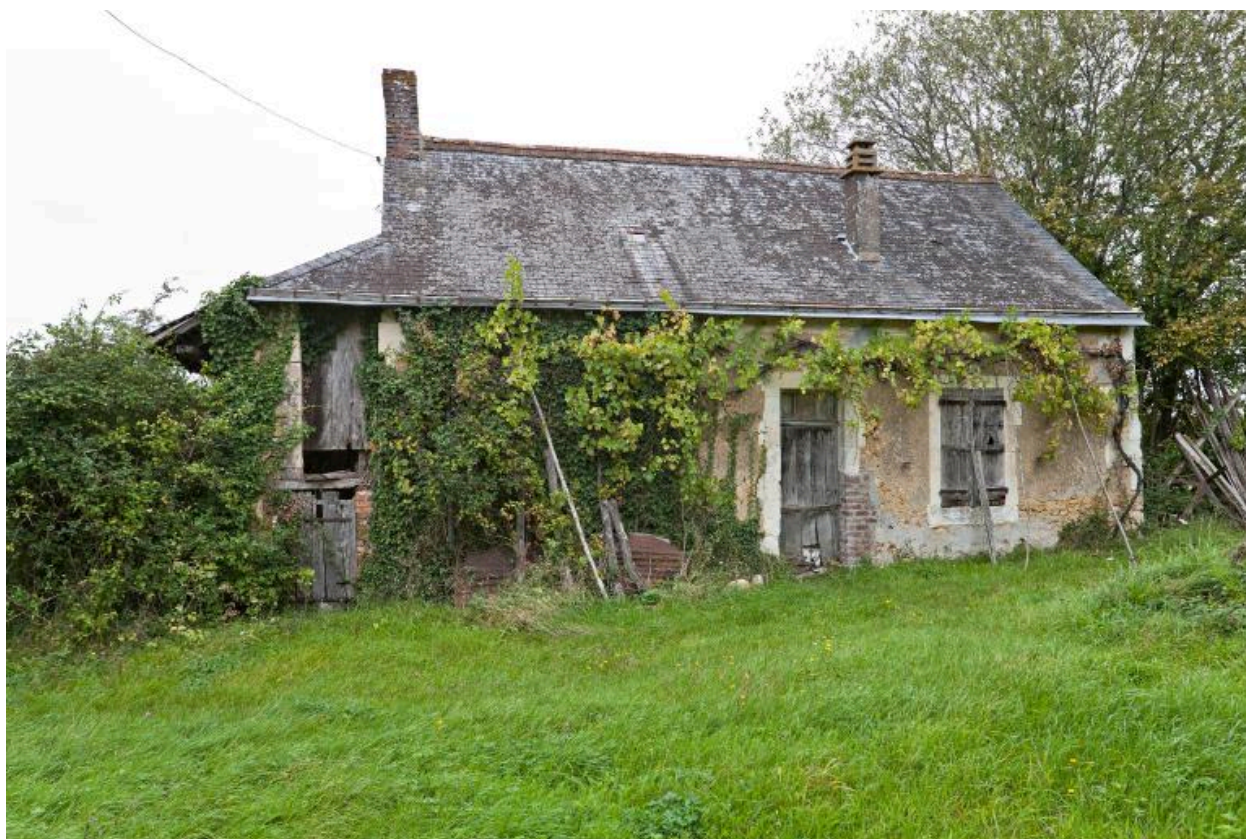
Maison : façade antérieure (sud).
