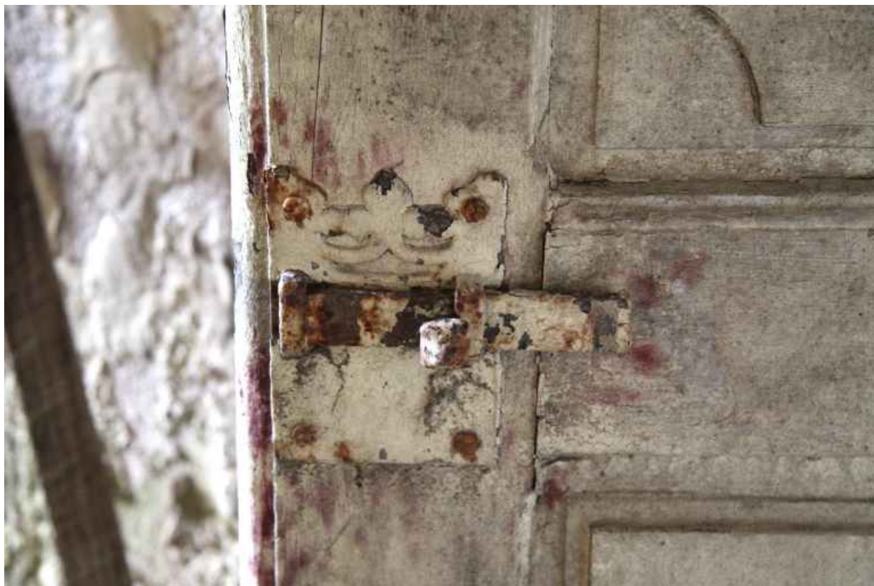
Porte de placard au 1er étage : loquet.
