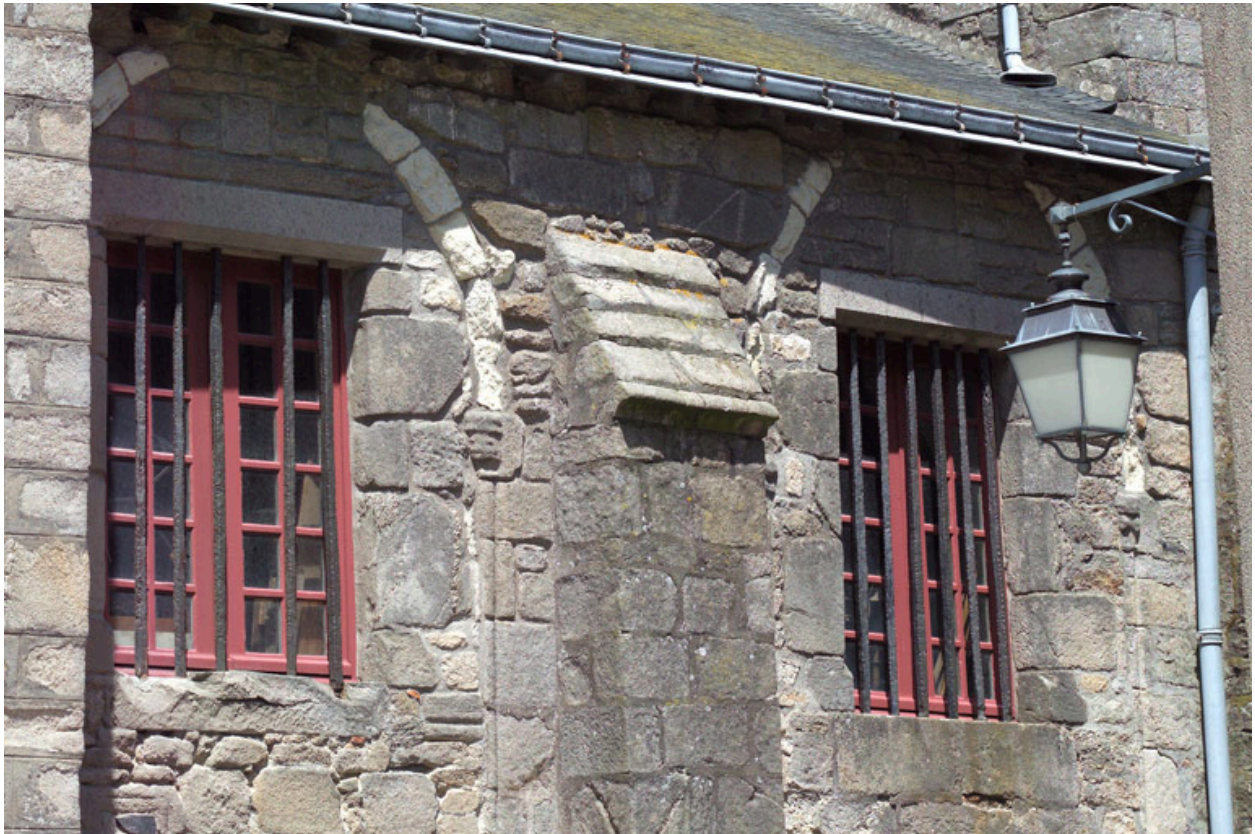
Mur sud, détail.
