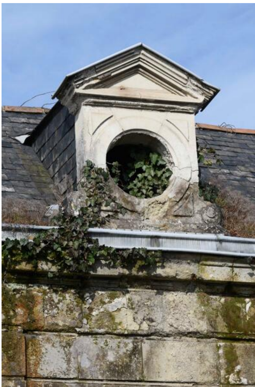
Détail de la lucarne du 6 rue d'Anjou.
