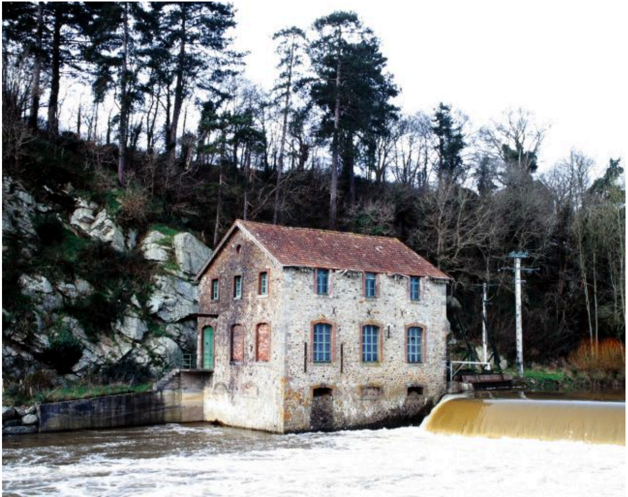
Vue de la rive gauche, en aval : façades sud et est.
