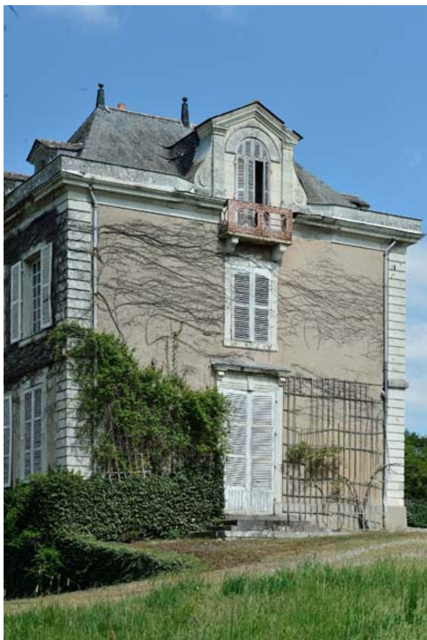
Mantelon. Château. Vue du pignon ouest.
