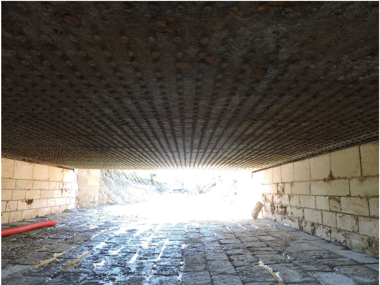
Août 2020 : le radier en fonte de 1894-1895 vu depuis l'amont.
