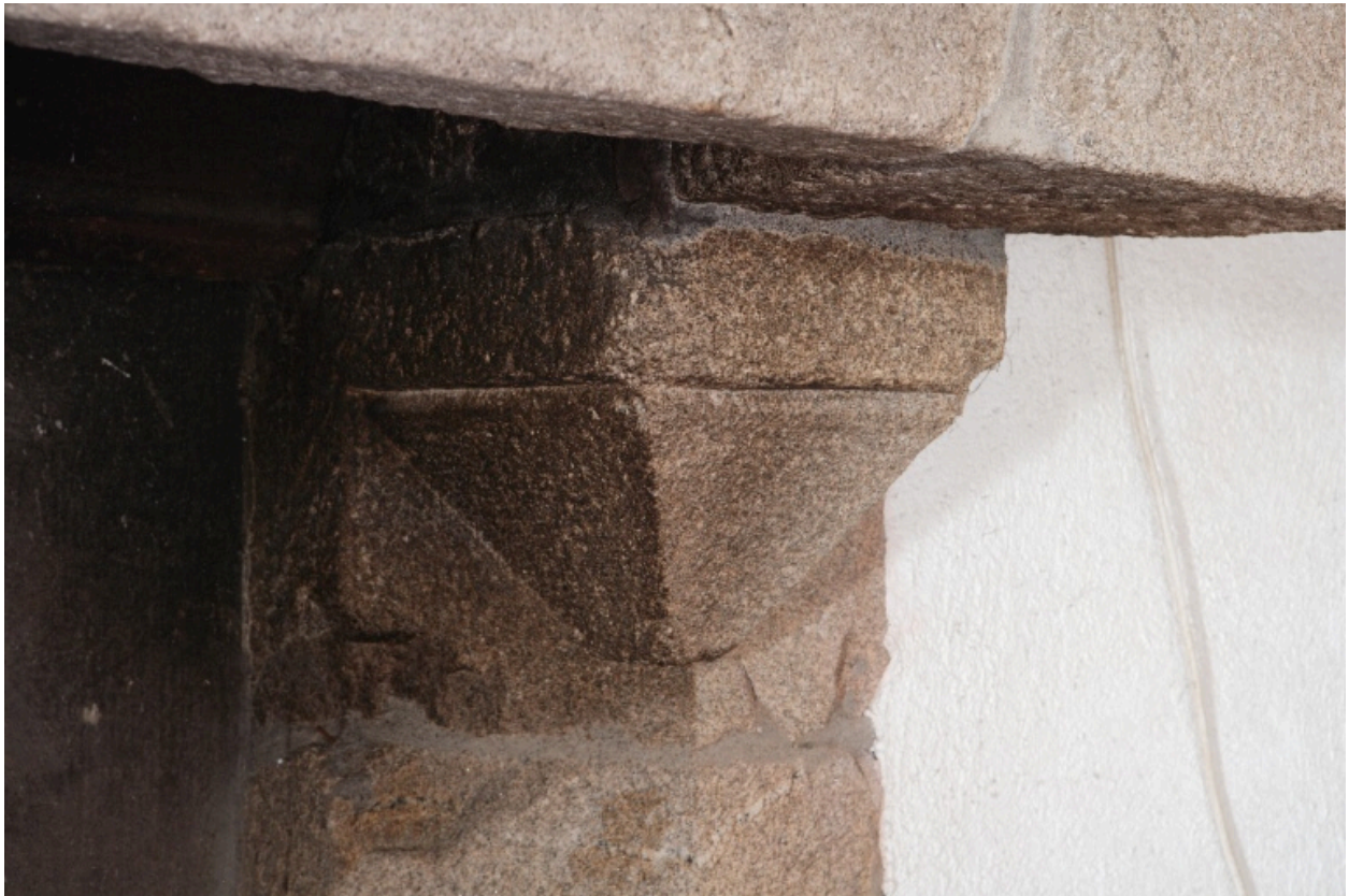
Détail de la console de droite de la cheminée du rez-de-chaussée du logis est.
