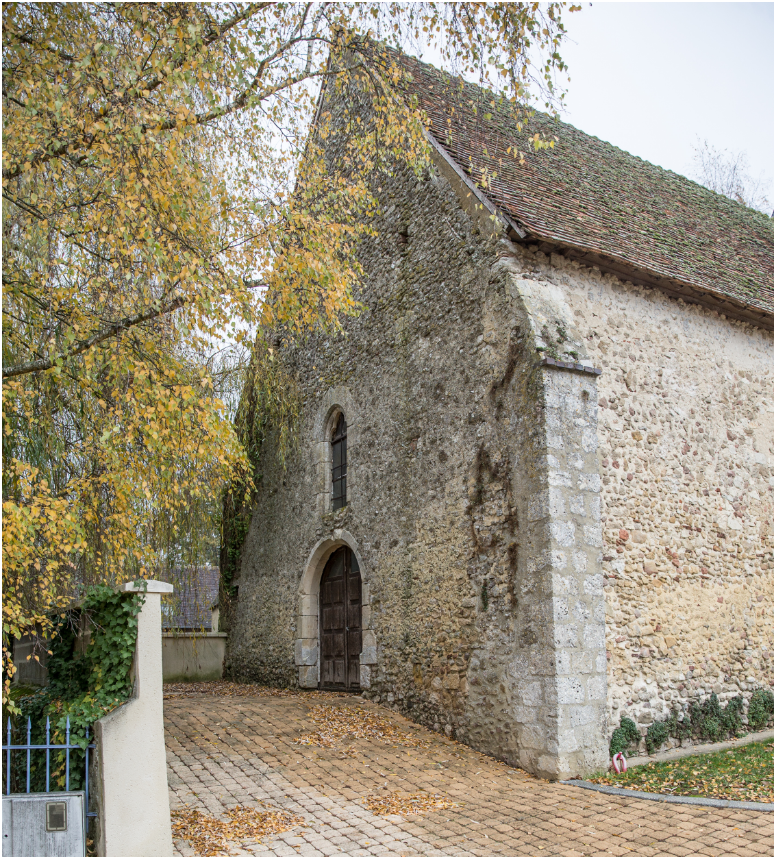
La façade occidentale de la nef.
