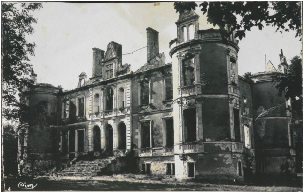
Le château après l'incendie. Carte postale, après 1950.
