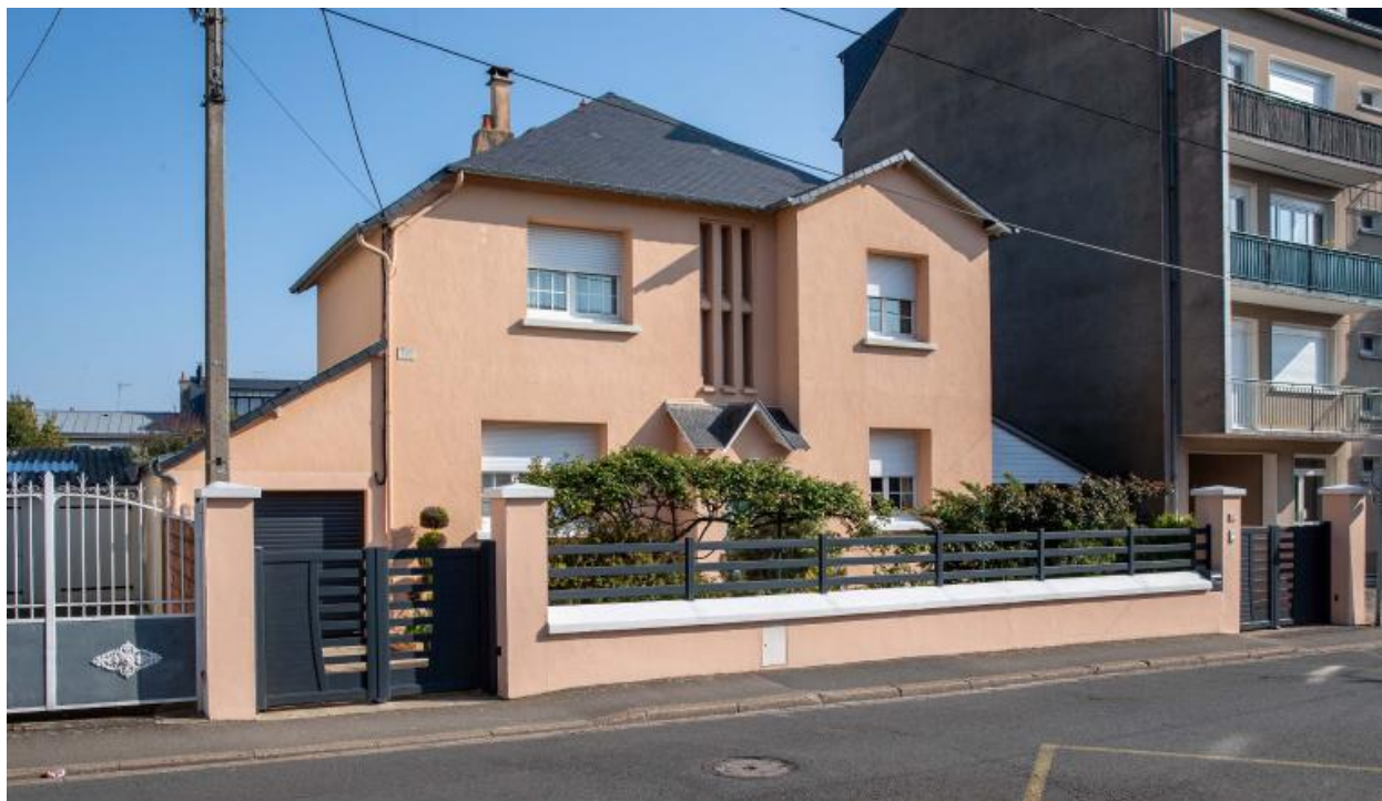
Vue de la maison réalisée par Schlutz, rue du Pavé.
