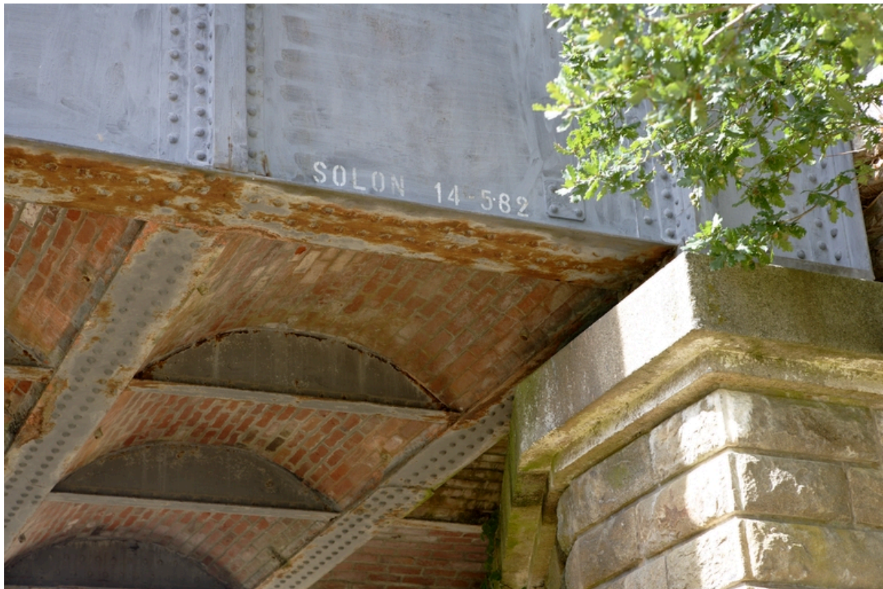
Pile (côté Châteaubriant).
