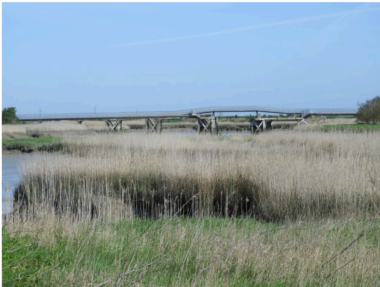
L'ancien pont à travers les marais, vu depuis le sud-est.
