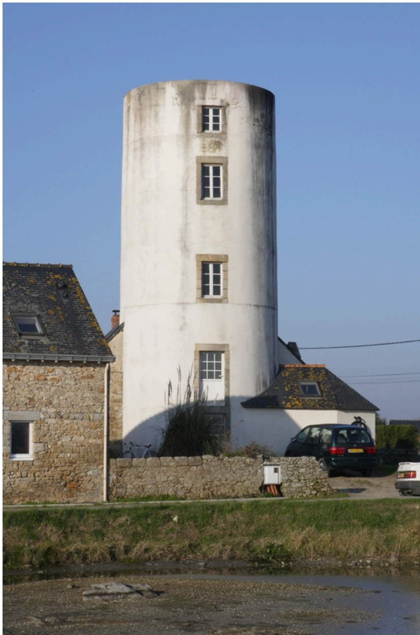
La tour du moulin. Vue prise depuis le nord-est.
