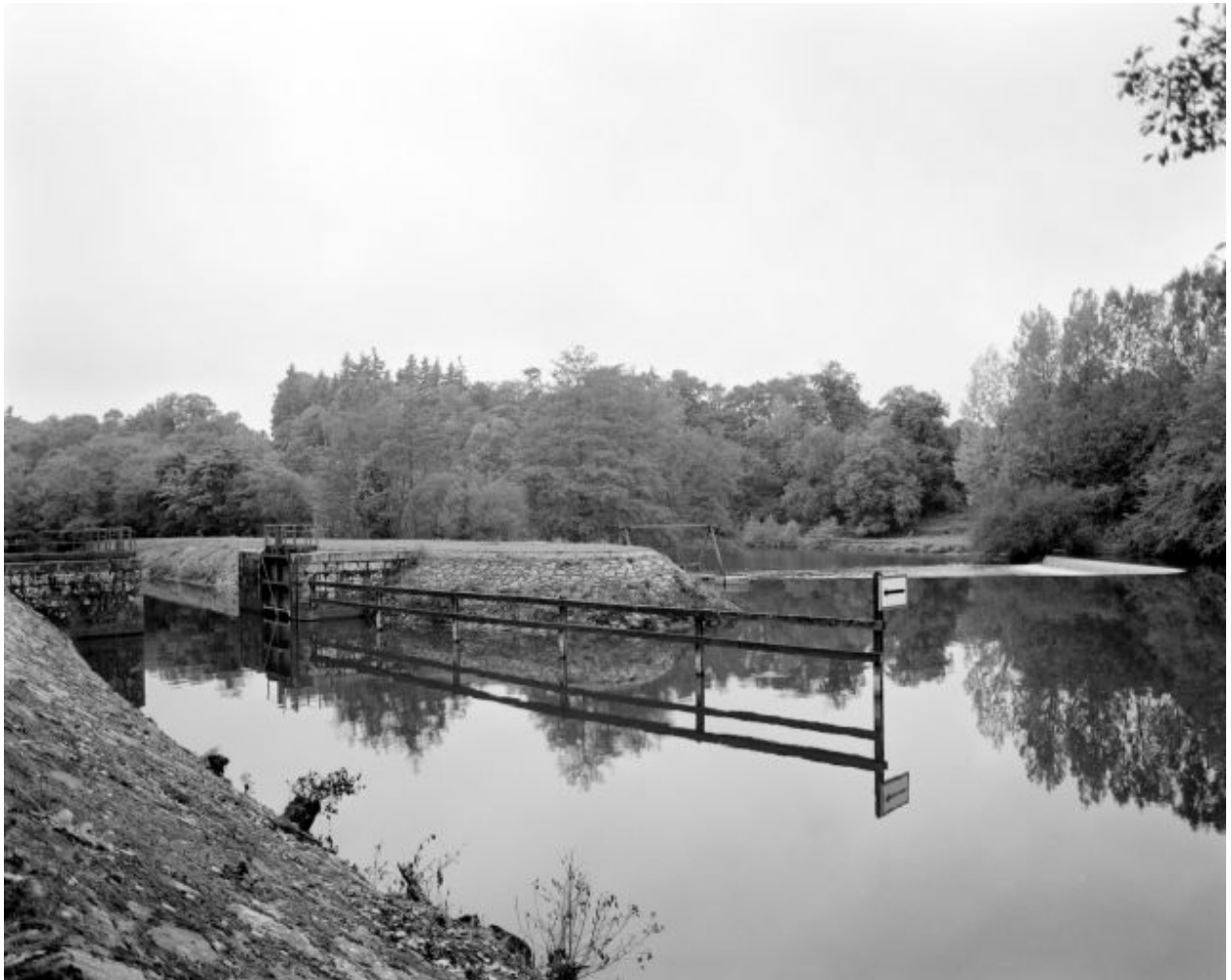
L'entrée d'amont du canal vu de la rive gauche.
